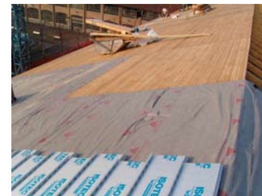
I pannelli Isotec in fase di posa
